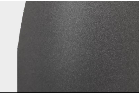
Detalle del acabado arenado del poste.
