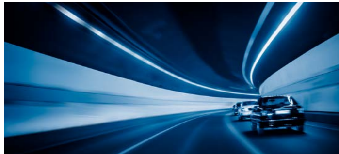
Iluminación de TÚNELES
